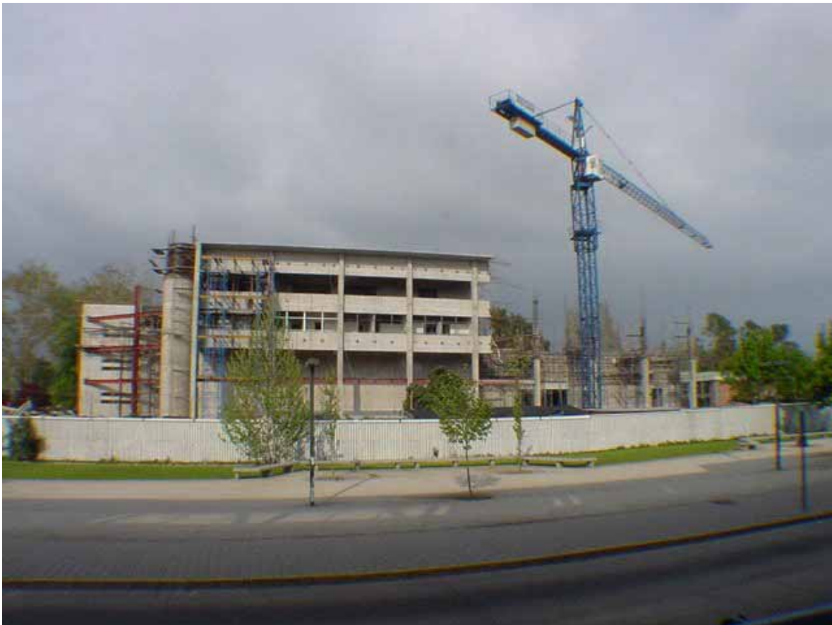
Fig. 2 Construcción del Edificio San Agustín de la Facultad de Ingeniería de la Universidad Católica
